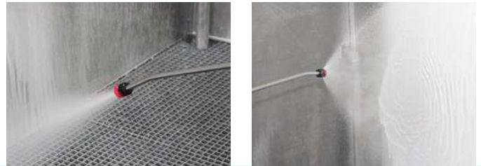
Reiniger auftragen mit Druckluft-Schaumlanze
